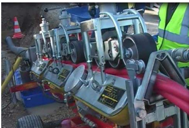
地下ダクトに電力ケーブルを導入している例 (使用機器: WATUCAB™)
