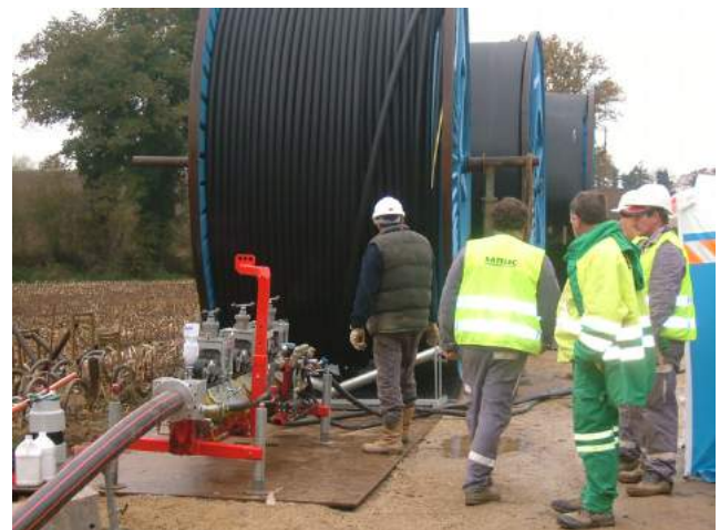
地下ダクトに電力ケーブルを導入している例 (使用機器: SUPERJET™)
