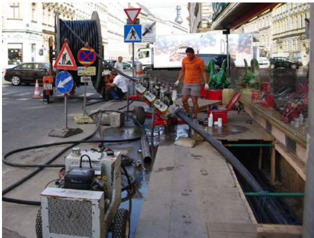
地下ダクトに電力ケーブルを導入している例 (使用機器: WATUCAB™)
