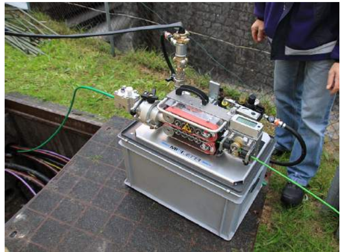
地下のダクトにマイクロダクト束を導入している例 （使用機器：SUPERJET™）
