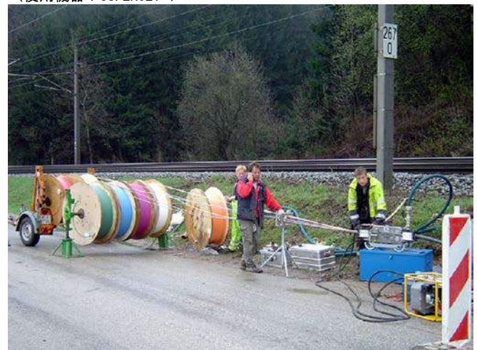
地下のダクトにマイクロダクト束を導入している例 （使用機器：SUPERJET™）
